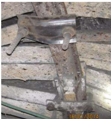
Рисунок 2 - Усиление крепи спаренными анкерами
