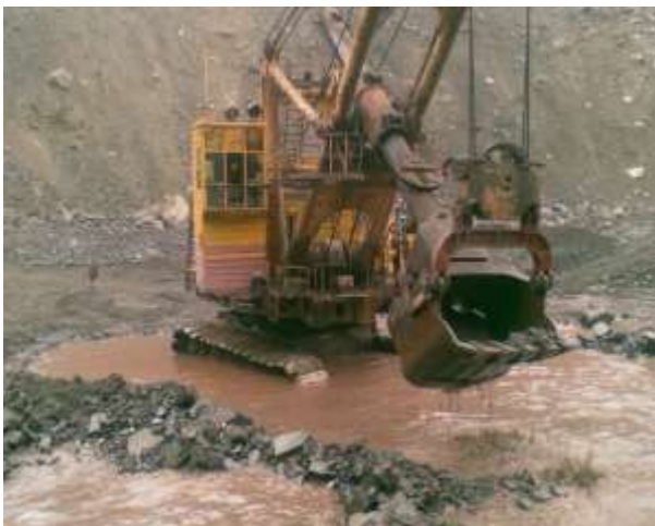
Рисунок 2 - Примеры строительства траншей в сложных гидрогеологических условиях железорудных карьеров Кривбасса
